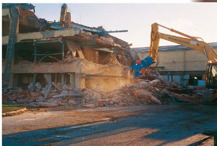
DEMOLICIONES EDIFICIOS DE HORMIGÓN
