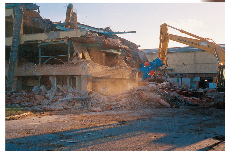
DEMOLICIONES EDIFICIOS DE HORMIGÓN
