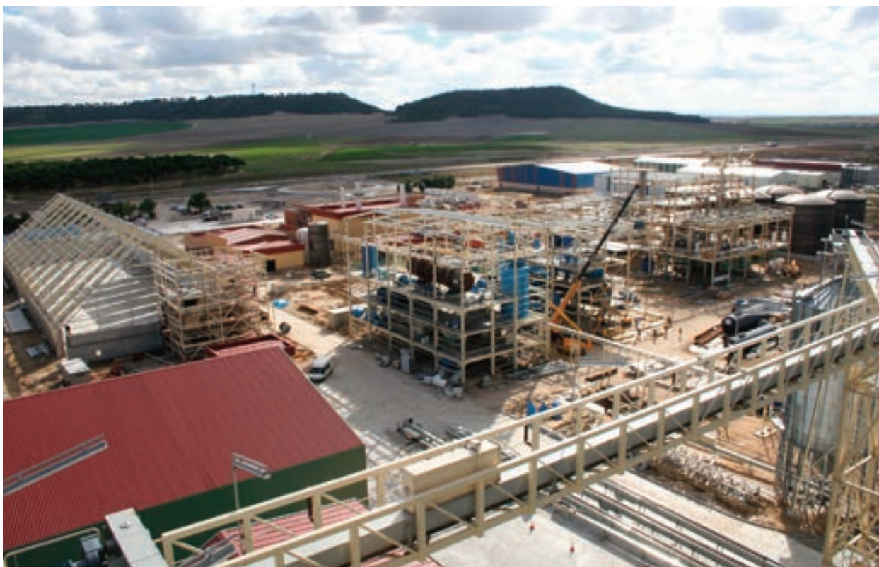
Imágenes de la planta de biodiesel en construcción.
