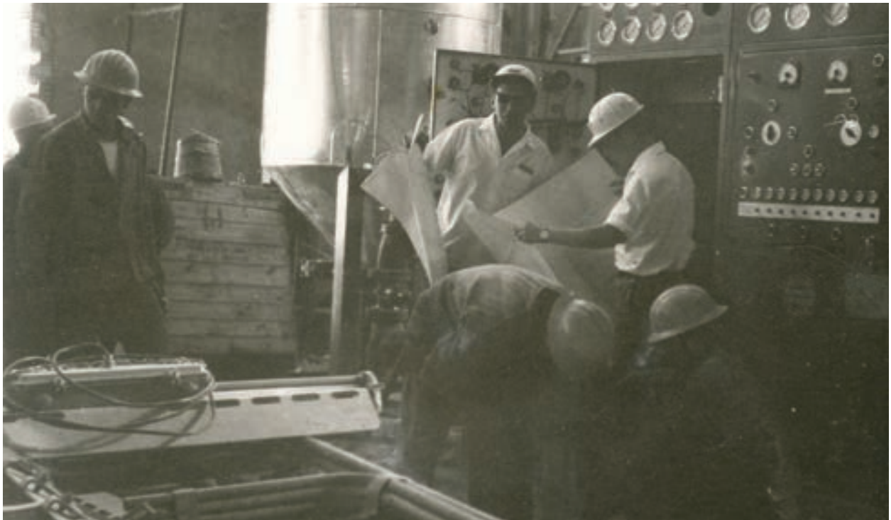
Trabajadores en las obras de construcción de la primera fábrica de ACOR.
