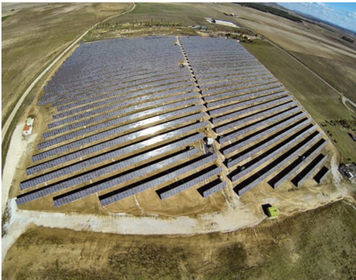
Parque Solar Fotovoltaico de Tordesillas.
