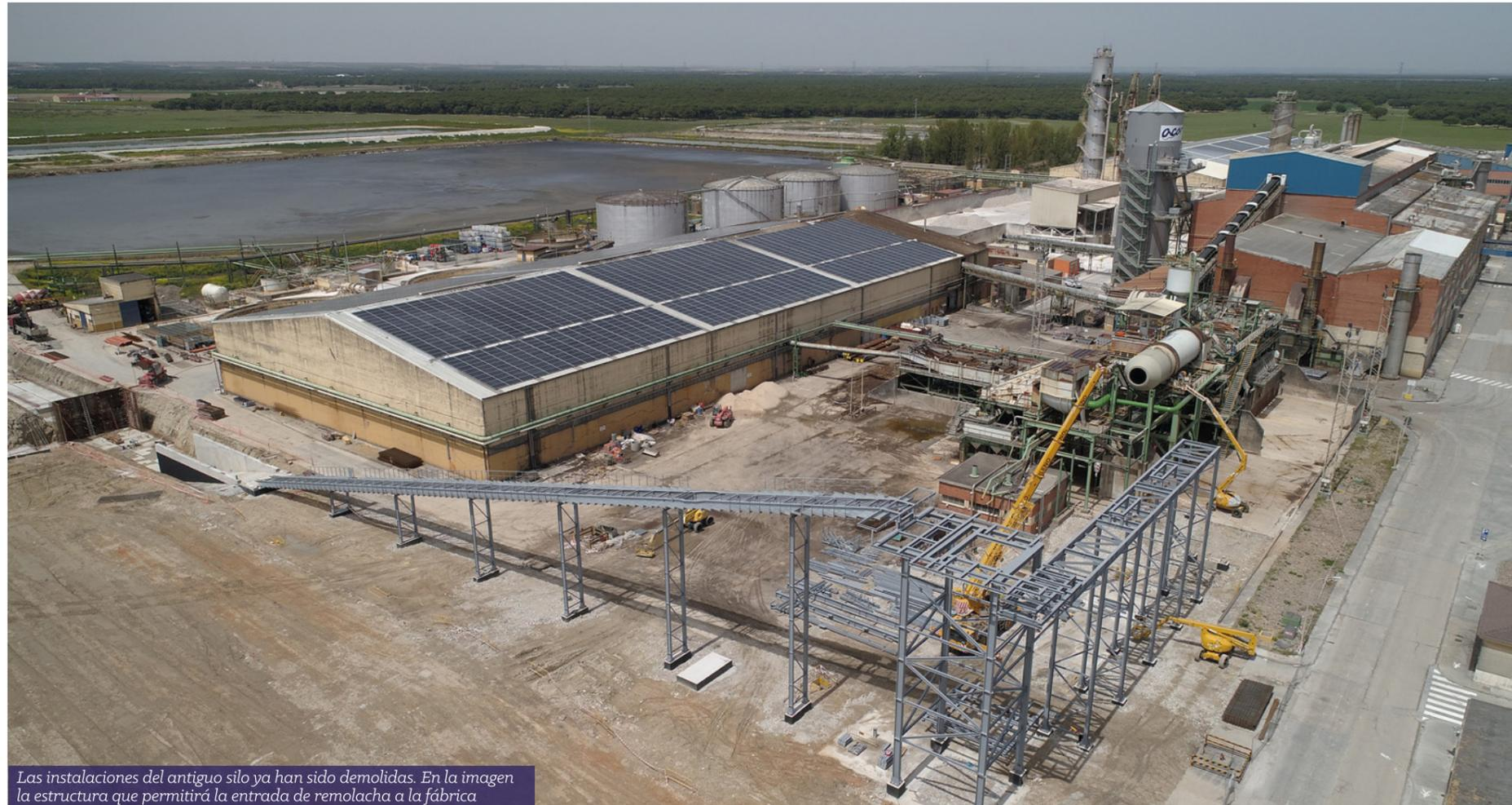
Las instalaciones del antiguo silo ya han sido demolidas. En la imagen la estructura que permitirá la entrada de remolacha a la fábrica
