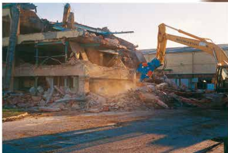
DEMOLICIONES EDIFICIOS DE HORMIGÓN
