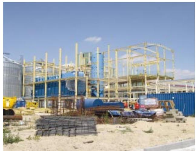
Igualmente han concluido ya, los trabajos de hormigonado correspondiente a la cimentación y las paredes de la nave de harinas. En breve se iniciará la instalación de la estructura y cerramiento de la misma.
