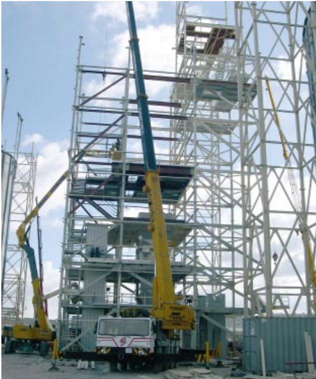
Planta. En estos días se está procediendo, al sellado o unión entre el hormigón de la cimentación con las chapas metálicas que conforman cada uno de los silos terminados. Se aprecian ya otros dos silos, a los que se les ha colocado ya la cubierta y las primeras virolas.
