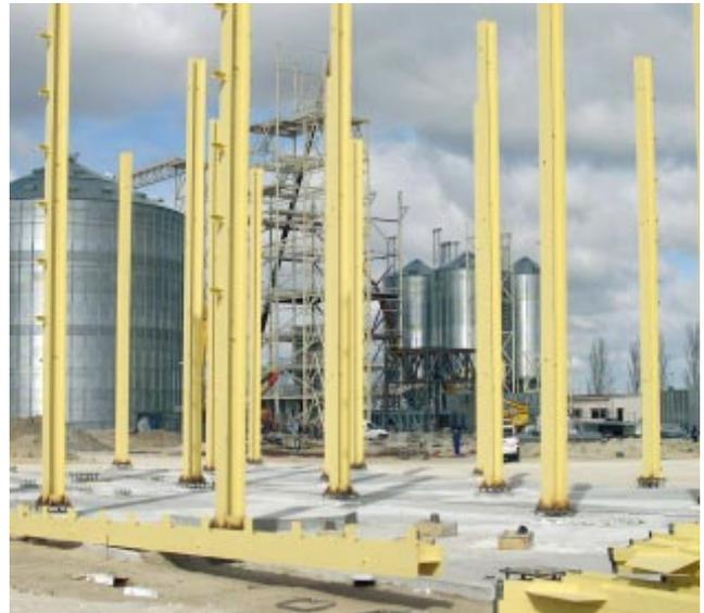
de 11'15 metros. Actualmente se está procediendo a echar el forjado de hormigón sobre la chapa colaborante situada en la cota +15,94 de dicho edificio.
